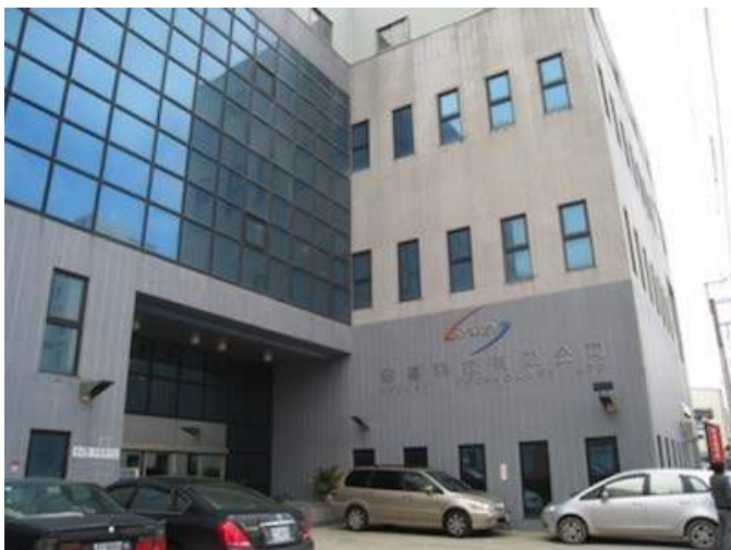
公司独立大楼
